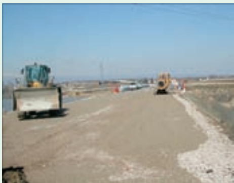
Esempio di mezzi d'opera semoventi in cantiere
