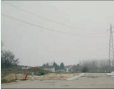
Situazione pericolosa per presenza di linee elettriche aeree in tensione non protette
