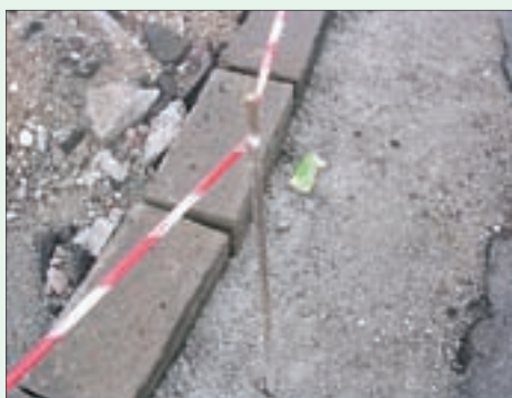
Situazione non regolare, il ferro sporgente dal suolo non è protetto
