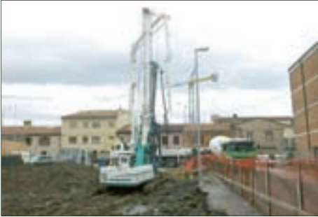
esempi di attività rumorosa svolta ai margini dell'area di cantiere
