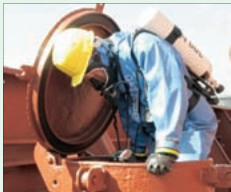
Esempi di lavori in luoghi confinati
