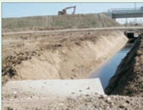
Situazione regolare, il fronte dello scavo è inclinato correttamente
