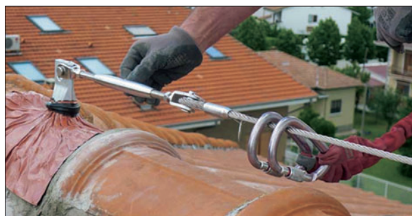
Figura 1 - Incorporazione tra ancoraggio e struttura di supporto.
