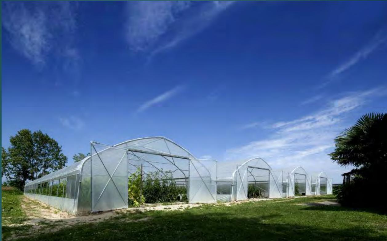
la struttura realizzata normalmente con tubolari ad arco di metallo e con copertura in film plastici leggeri o con reti ombreggianti, **non collegata a fondazioni murarie reticolari o lineari**, facilmente smontabile e rimovibile. In essa il film di copertura, superficiale o laterale, è steso per la durata della stagione agronomica, al termine della quale deve essere obbligatoriamente rimosso o, in alternativa, ripiegato o avvolto lateralmente alla struttura.
